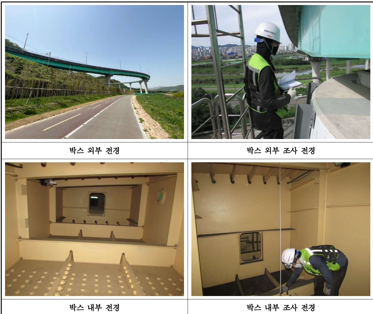
【사진 3.6】 강박스 거더 전경
