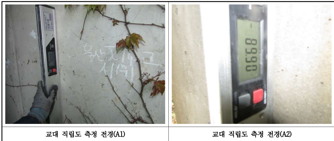
【사진 3.14】 교대 변위(직립도) 측정 전경
