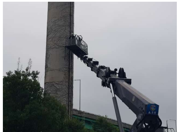
고소작업차를 이용한 현장조사
