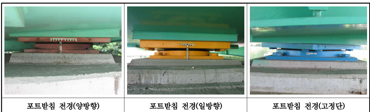
【사진 3.18】 교량받침 설치전경
