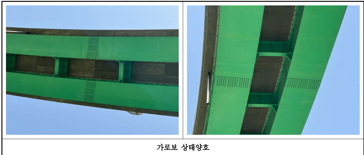
【사진 3.11】 2차부재(가로보) 손상현황
