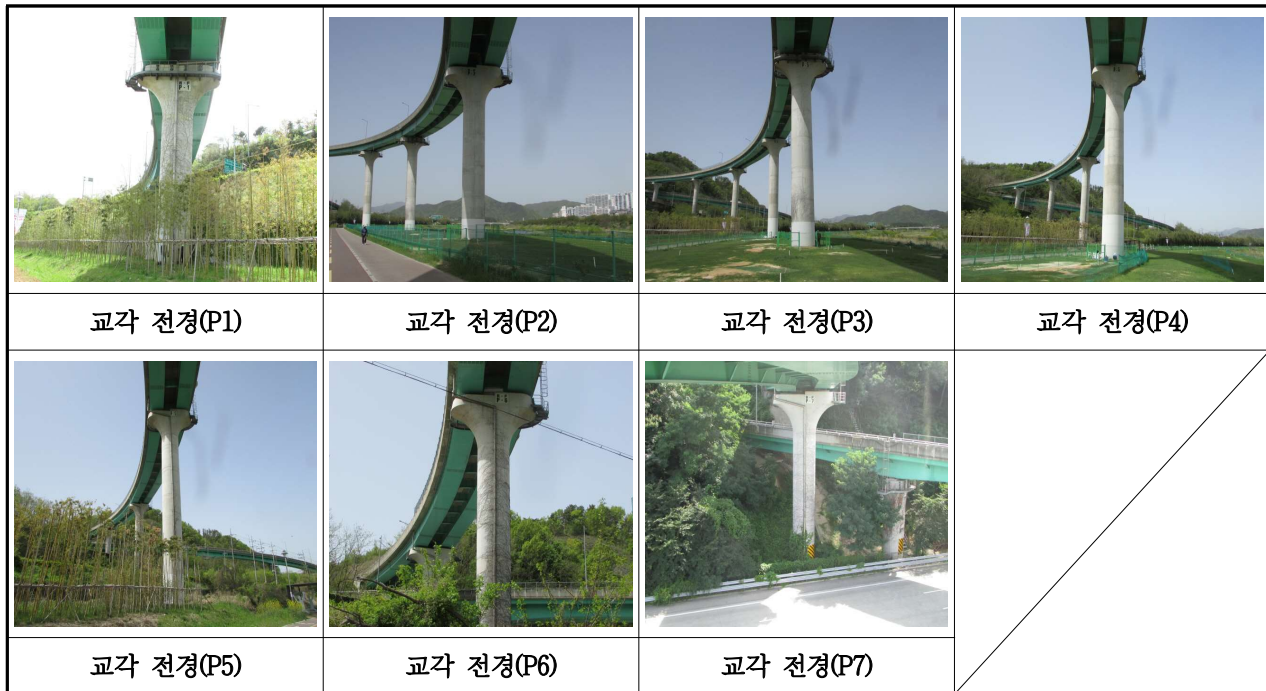
【사진 3.15】 교각 전경
