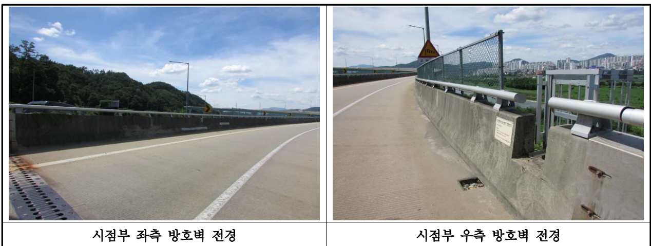
【사진 3.26】 난간 및 연석(방호벽) 전경
