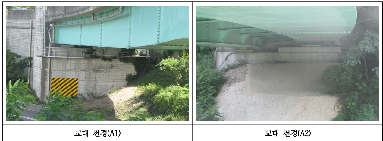
【사진 3.12】 교대 전경
